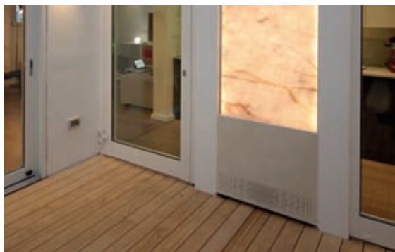
L'ingresso della Smart House con una pavimentazione con listelli in legno su lastre Knauf Brio
