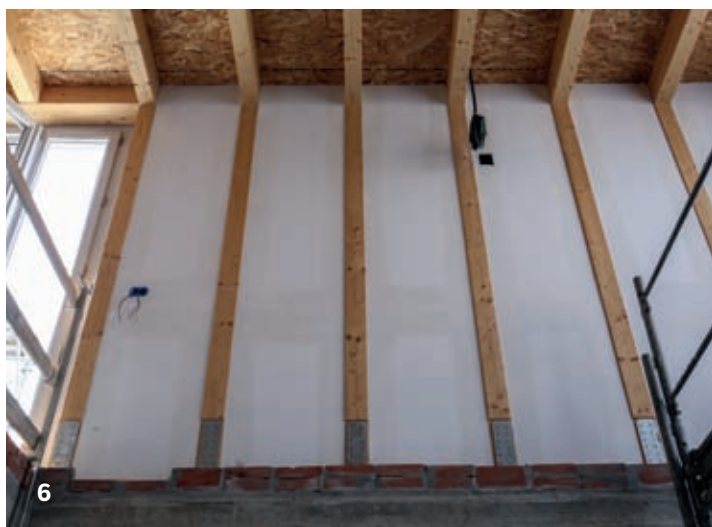
5 Interno, pareti di partizione. Realizzazione con schema Knauf W112
