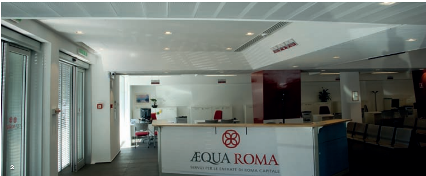
1-2 Interno, atrio. Ottimizzazione delle superfici fonoassorbenti tramite l'utilizzo di controsoffitti e velette.
